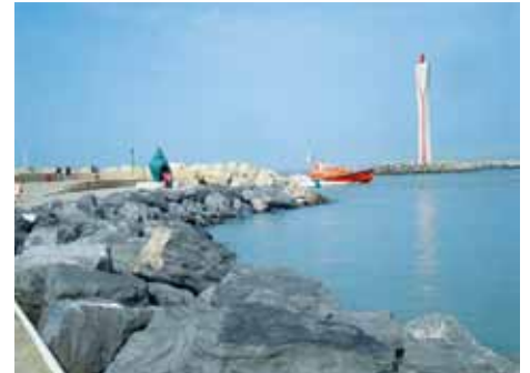
Neuer Pier, Oostende
