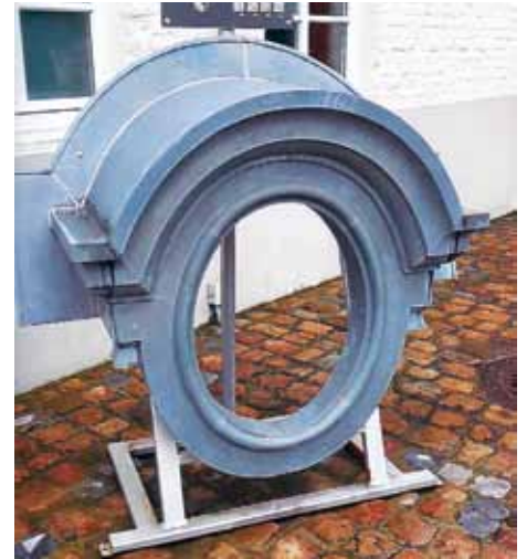
Dachfenster aus Zinkblech
