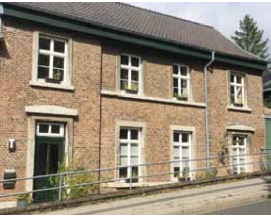
Alte Volksschule, heute Wohnhaus Albert-Einstein-Straße 35
